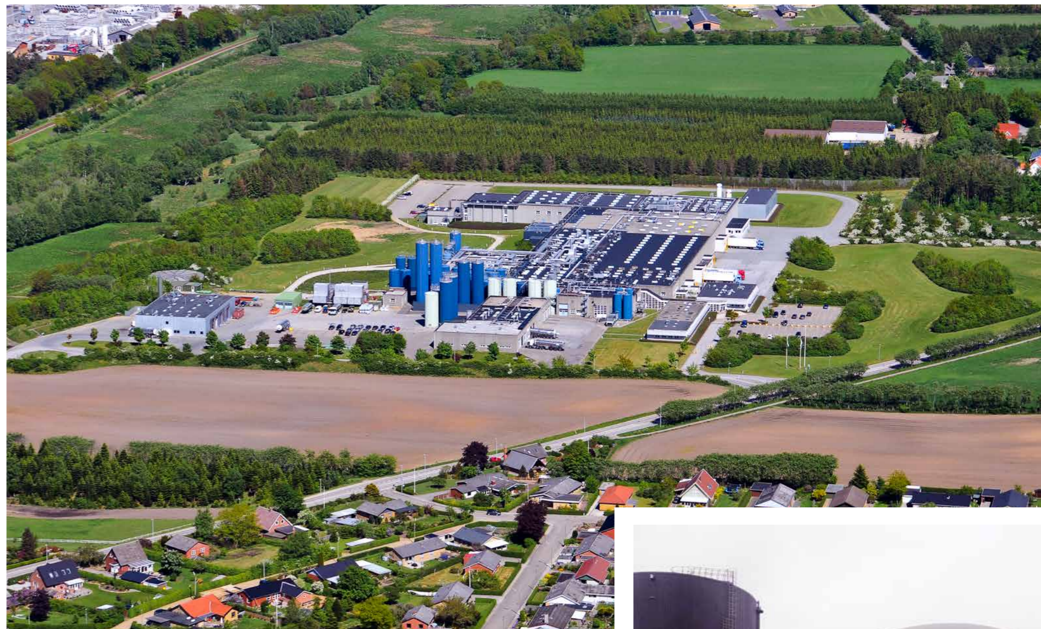
Rødkærsbro Mejeri, som sender overskydende varme fra osteproduktionen videre til fjernvarmeværket.
